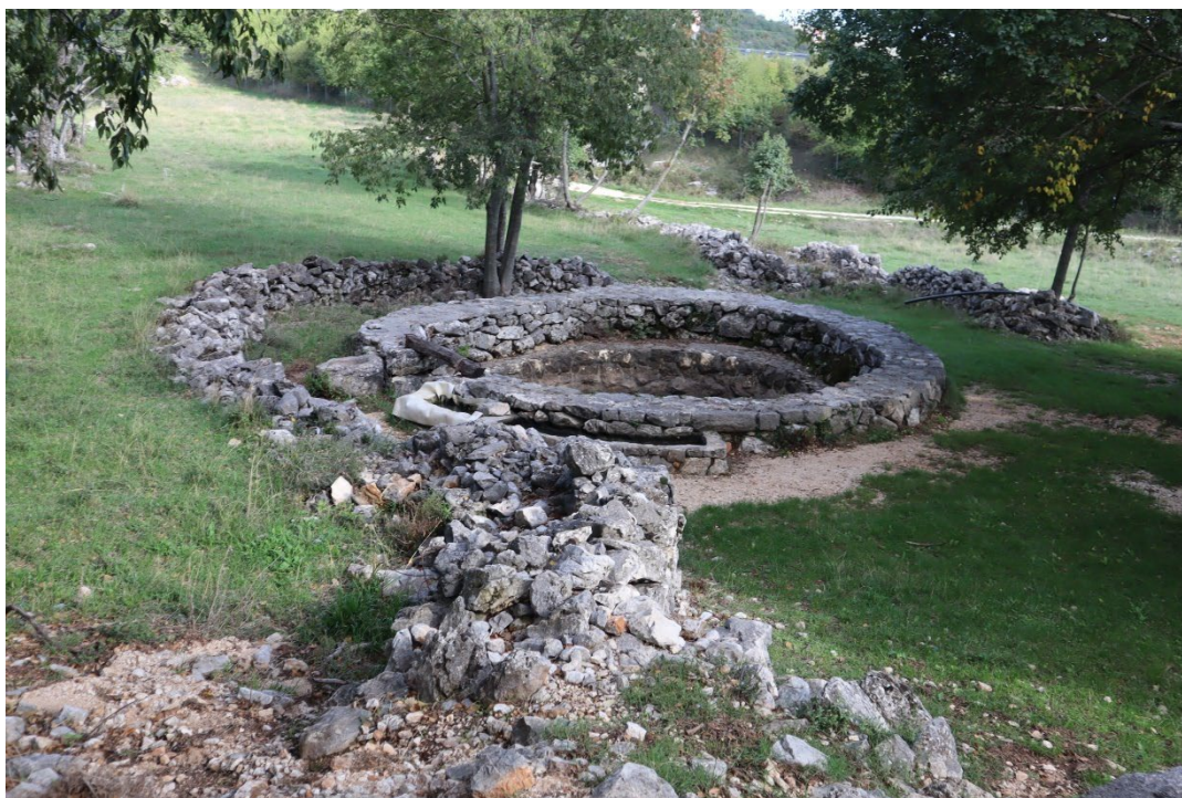
Slika 16 – Lokva u zaselku Količ, Dugopolje (Autor: 3E PROJEKTI d.o.o.)
