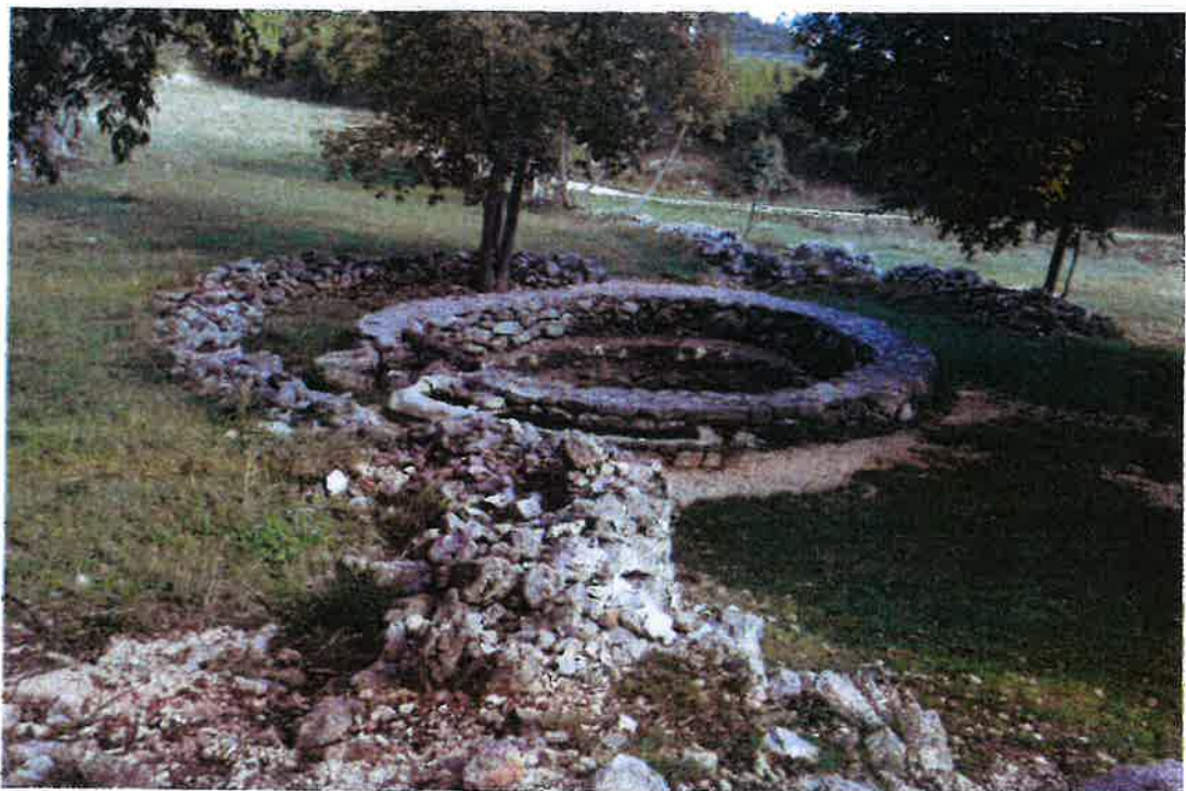
Slika 16 – Lokva u zaseku Količ, Dugopolje (Autor: 3E PROJEKTI d.o.o.)
