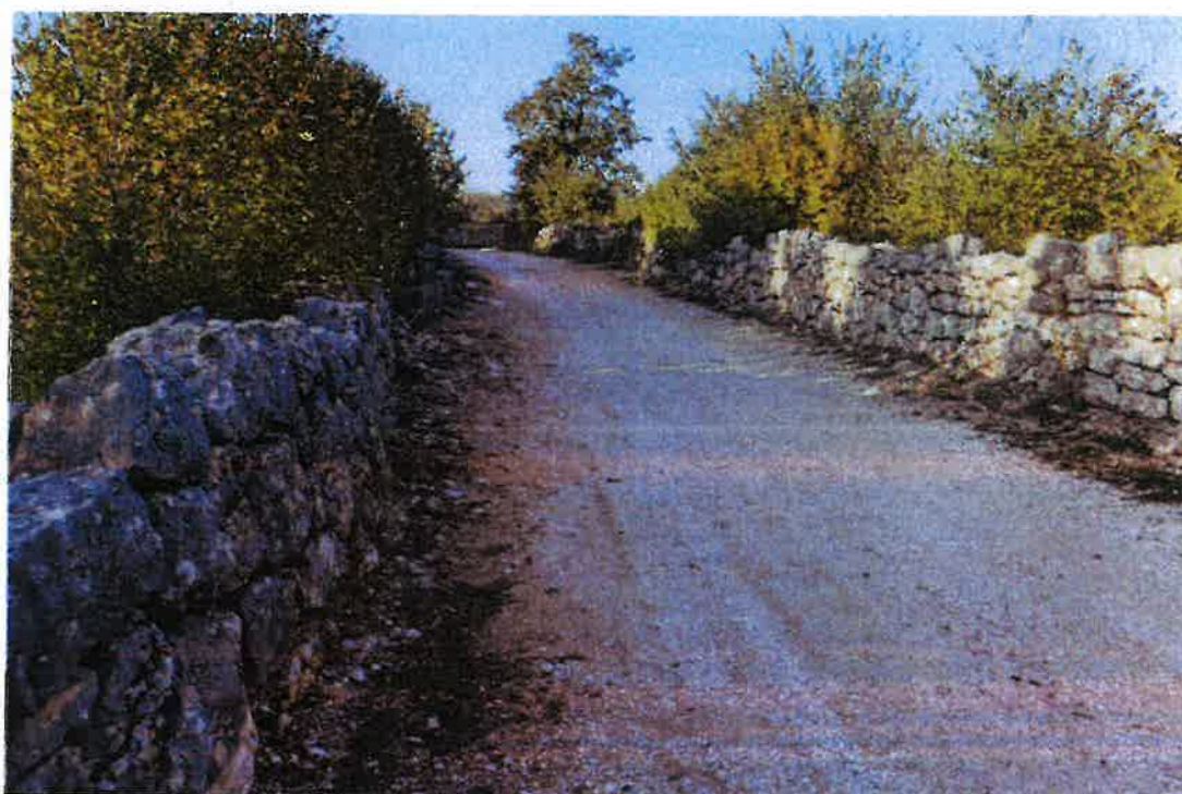
Slika 85 - Makadamski putevi ograđeni suhozidom (Autor: 3E PROJEKTI d.o.o.)
