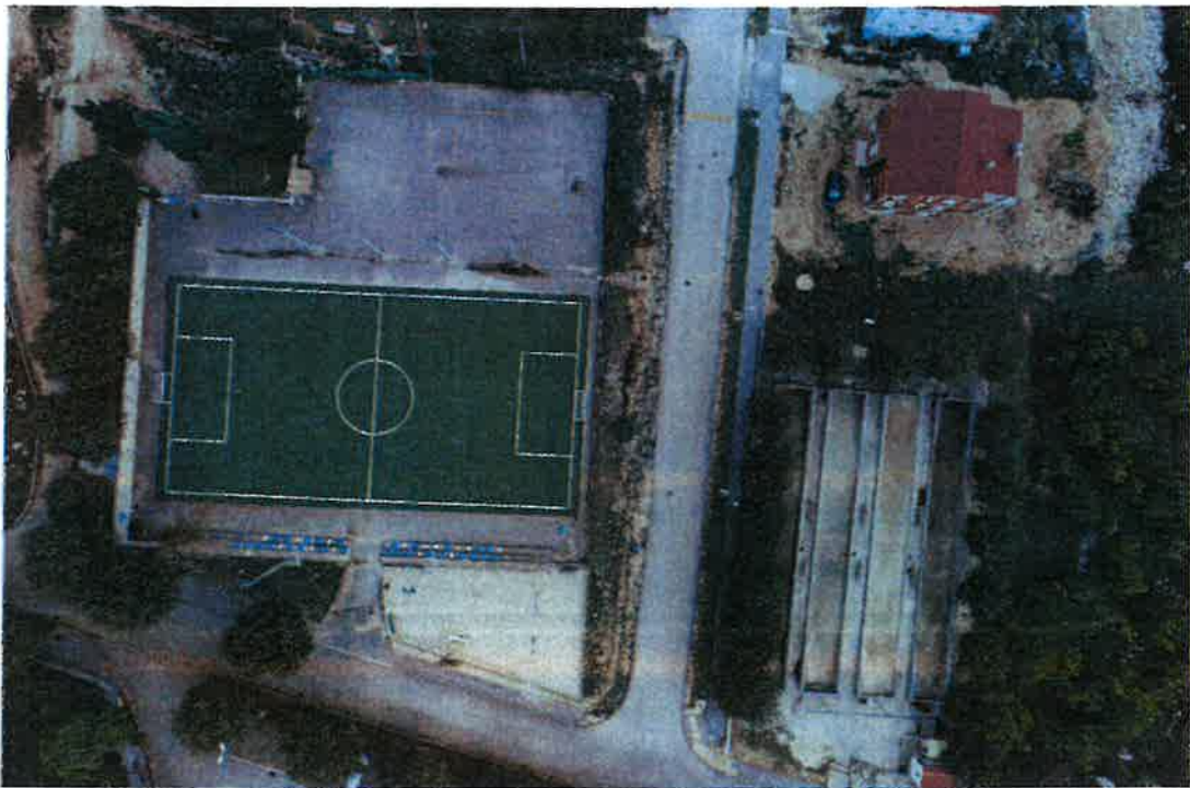
Slika 30 - Sportski sadržaji (bočalište, nogometni teren) u Koprivnom (Autori: 3E PROJEKTI d.o.o. i Andlar)
